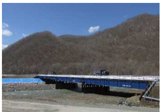
仮橋架設完了
