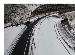
復旧工事完了
