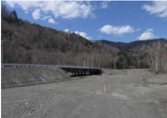
仮橋架設完了
