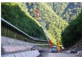
基礎復旧工事完了
