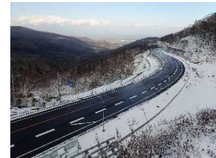
復旧工事完了
